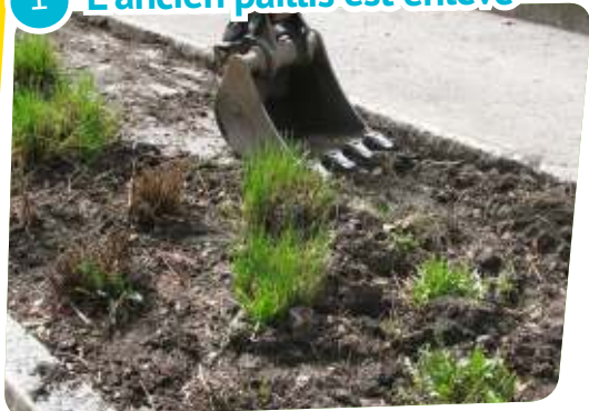
1 L'ancien paillis est enlevé
